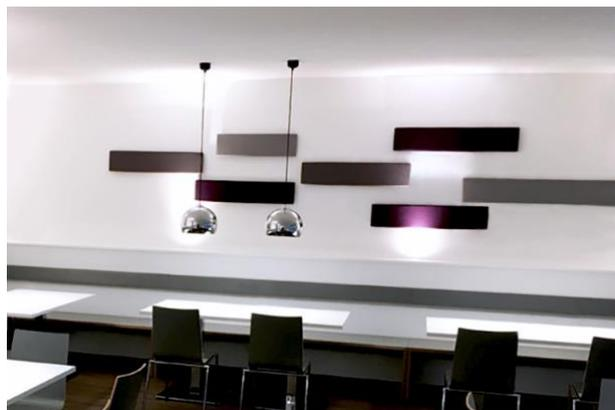
Top-Phon® Akustikpaneele sind moderne, effizient schalldämmende und individuell gestaltbare Akustikelemente für jegliche Räumlichkeiten. Sie bestehen aus einer hochwertigen Stoffbespannung, einer Absorberfüllung und einer Trägerplatte, welche gleichzeitig eine stabile Aufhängung für Akustikpaneel bietet. Das Top-Phon® Akustikpaneel hat eine Bautiefe von 50 mm, 100 mm oder 150 mm und kann mit oder ohne Abstand zur Wand montiert werden.
